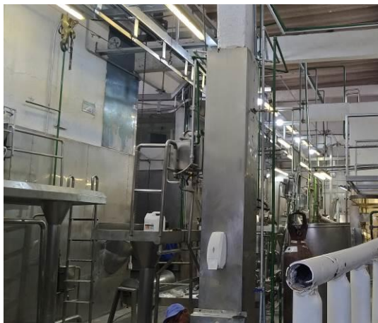
Foto 01. Vista interna do empreendimento
