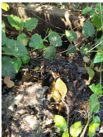
Foto 11. Ponto com comunicação de efluente bruto e rede pluvial, com extravasamento para solo (antes da adequação).
