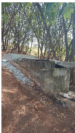
Foto 11. Caixa de armazenamento de água de chuva
