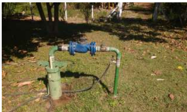
Foto 01. Poço Tubular Profundo
