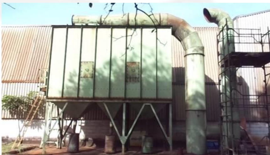
Figura 5: Filtro de manga da cabine de jateamento.
