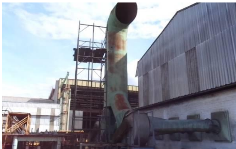
Figura 6: Chaminé da cabine de pintura com exaustores.
