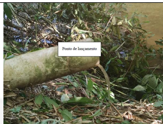
Foto 34: Ponto de lançamento
