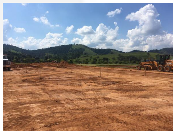
Foto 10: Nivelamento do solo
