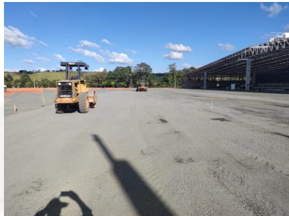
Foto 16: Colocação de britas
