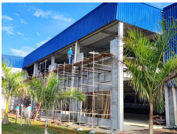
Fotos 25, 26, 27 e 28: Construção com blocos de concreto estrutural das paredes de fechamento do galpão.
