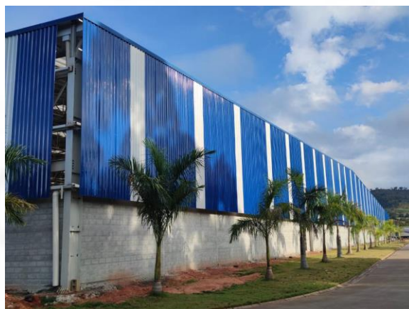
Fotos 25, 26, 27 e 28: Construção com blocos de concreto estrutural das paredes de fechamento do galpão.
