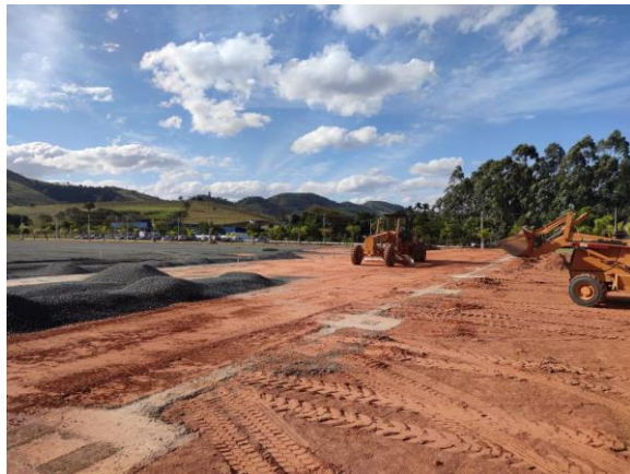
Foto 15 : Colocação de britas
