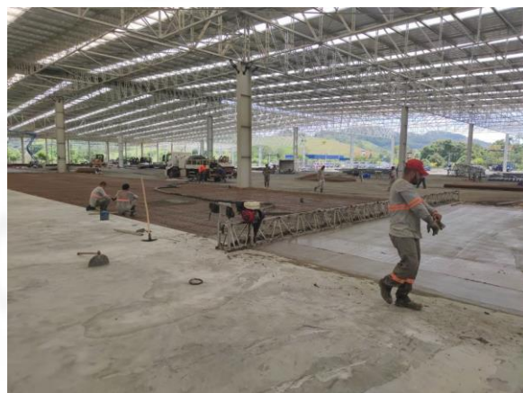
Foto 18: alisamento dos pisos
