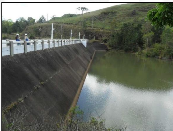
Figura 5: Talude de montante. Vista para a ombreira direita.
