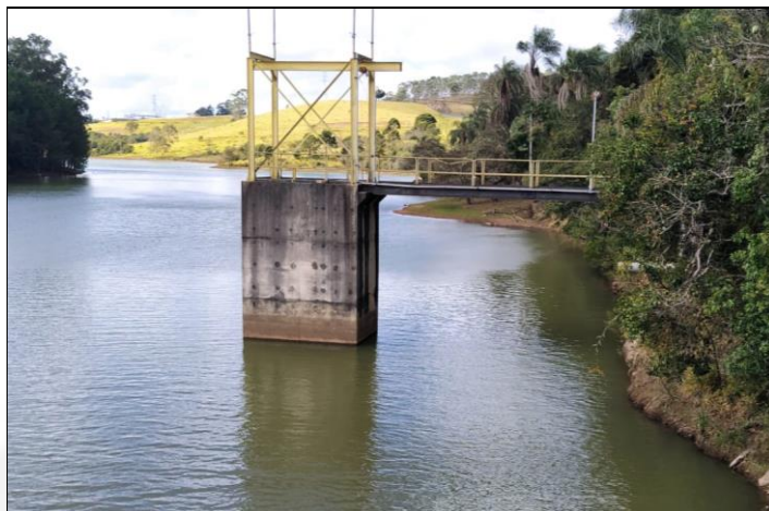
Figura 13: Foto da tomada d'água.
