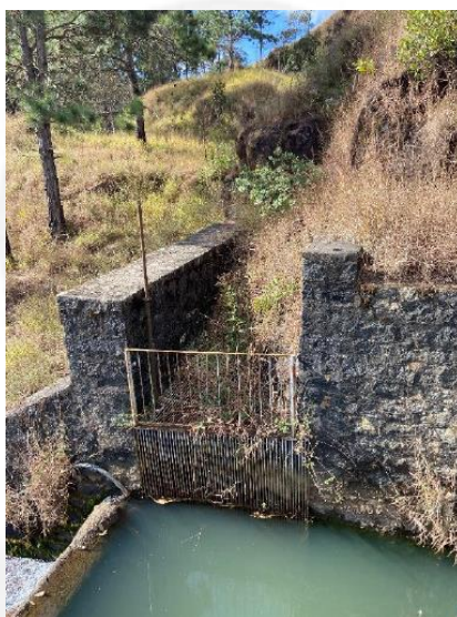
Figura 17: Ponto de captação superficial e gradeamento na captação. Fonte: RCA
