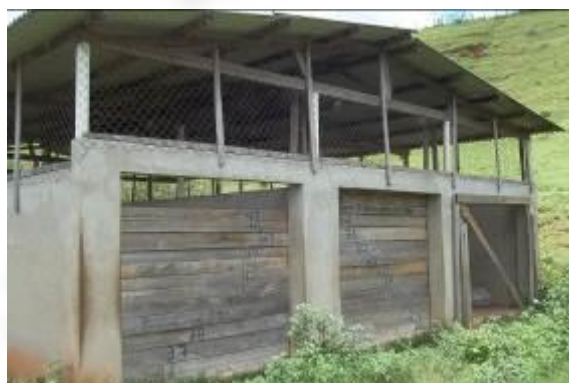
Foto 10. Galpão de compostagem.
