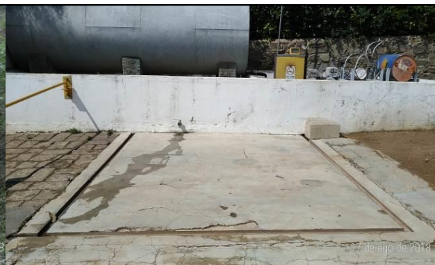
Foto 08 – Tanque de combustível, piso impermeabilizado e canaletas
