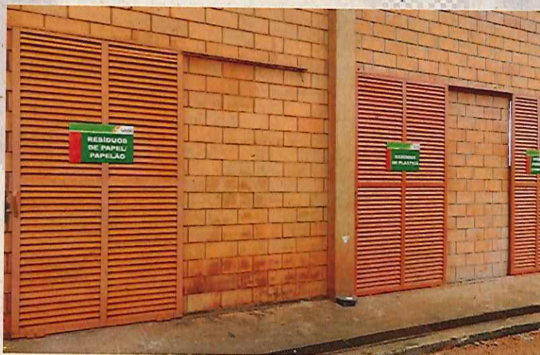
Figura 25- Galpão de armazenamento de resíduos Protocolo R063342/2018
