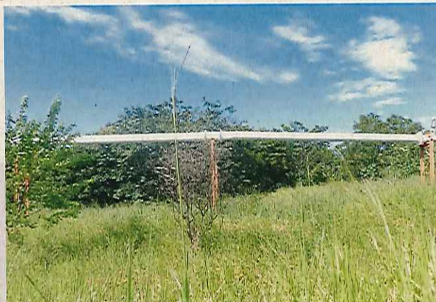
Figura 6- Adutora que substituiu tubulação quebrada.
