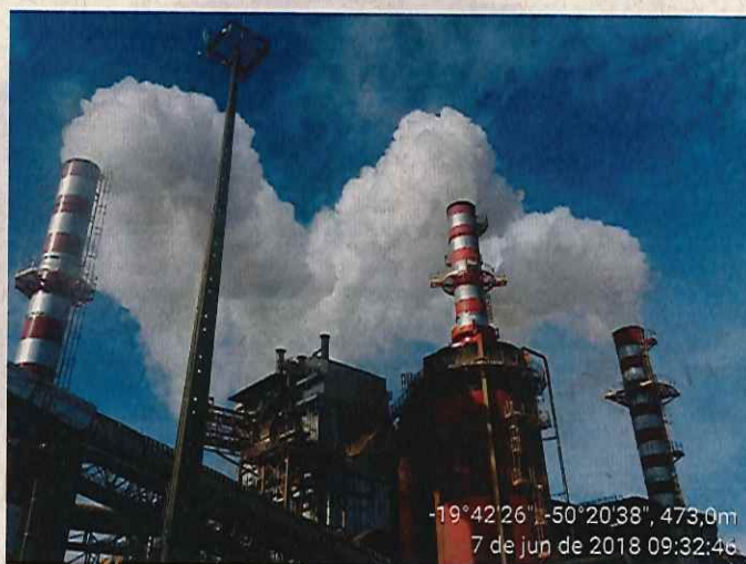
Figura 18- Caldeira utilizada na queima do bagaço de cana-de-açúcar.
