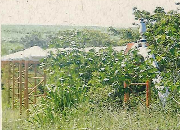
Figura 5- Adutora que substituiu tubulação quebrada.
