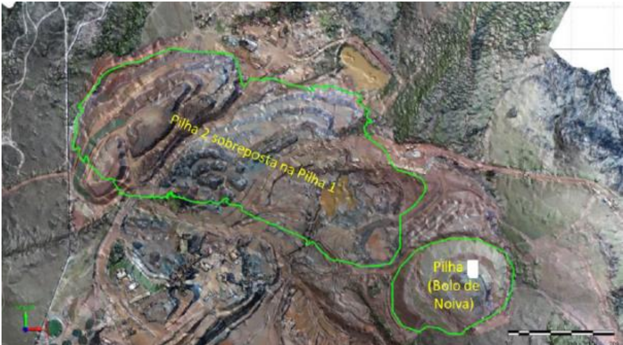
Figura 2.2: Área de unificação das pilhas 1 e 2. Fonte: PU 37/2024 referente à LOC nº 901/2021.
