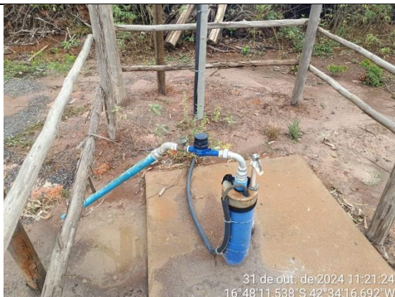
Foto 7 – Poço tubular para captação de água
