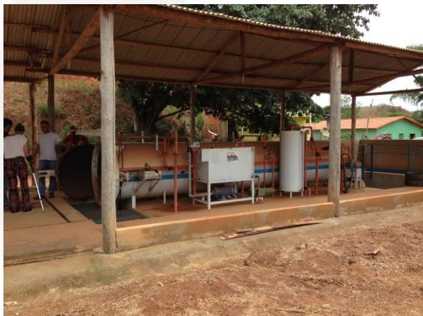
Foto 03. Detalhe do local de instalação da bacia de contenção, onde foi instalada a autoclave e canaletas.
