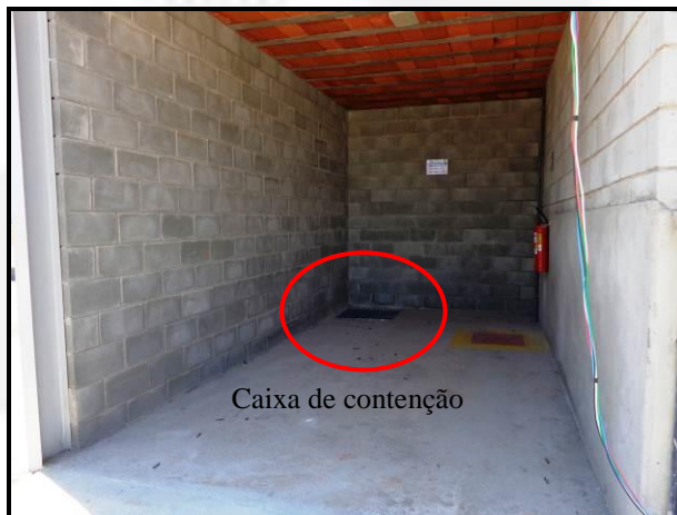
FOTO 04 – Área de compressores com caixa de contenção.
