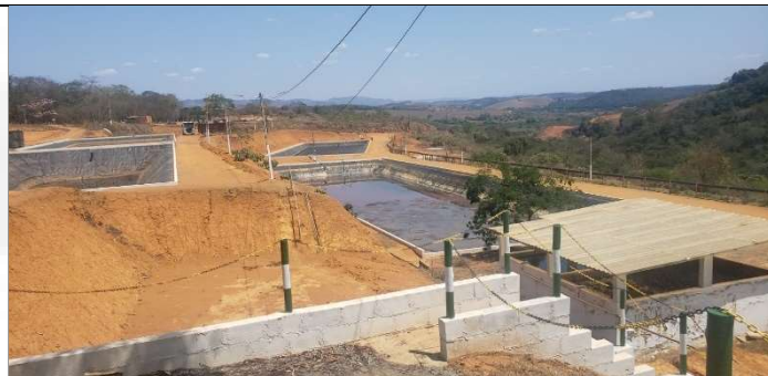
Foto 04: Vista das lagoas que compõem o sistema de tratamento do percolato e leito de secagem do lodo
