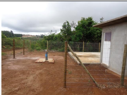
Foto 13: Poço tubular, captação hídrica.
