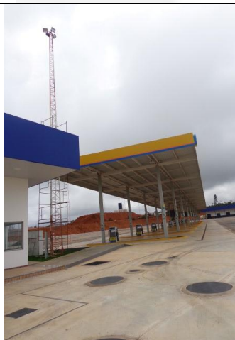
Foto 3: Tanques de combustível e bocas de descarga ao lado da pista de abastecimento.
