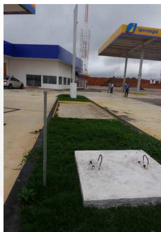
Foto 3: Tanques de combustível e bocas de descarga ao lado da pista de abastecimento.
