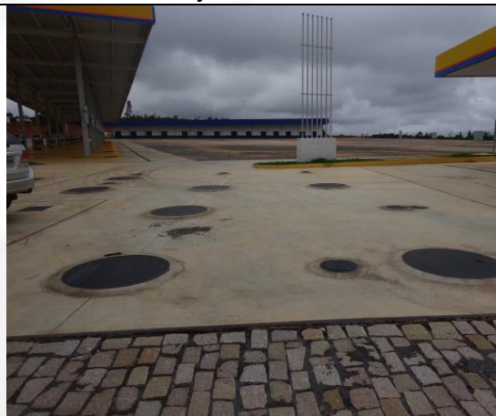
Foto 4: Acesso aos tanques de combustíveis suspiros.
