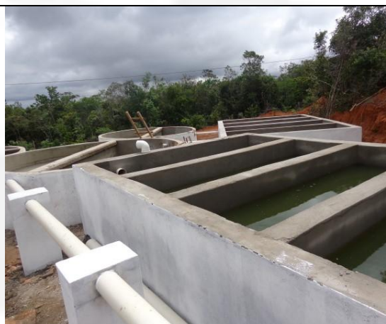
Foto 10: Sistema séptico, com filtro e sumidouro
