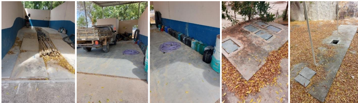
Fotos 1, 2, 3, 4 e 5 – Estruturas de apoio do empreendimento – pátio de manutenções coberto, com piso impermeabilizado e canaletas derivando para sistema separador de água e óleo; Caixas SÃO; sistema de tratamento de efluentes sanitários.
