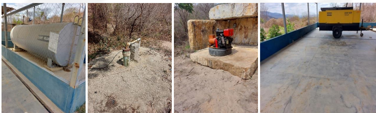
Fotos 6, 7, 8 e 9 – Estruturas de apoio do empreendimento – tanque de armazenamento e pátio de abastecimento de combustível diesel; ponto de captação hídrica subterrânea (hidrômetro e horímetro); galpão coberto com gerador de energia e compressor de ar.
