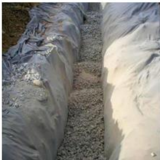
Figura 5-2 Barreira de Siltagem Geotextil
