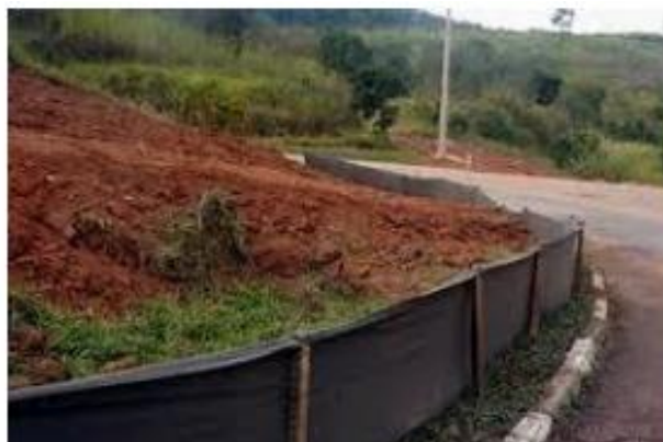
Figura 5-2 Barreira de Siltagem Geotextil
