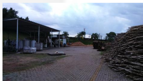
Foto 02. Local de armazenamento e preparação de cavacos.
