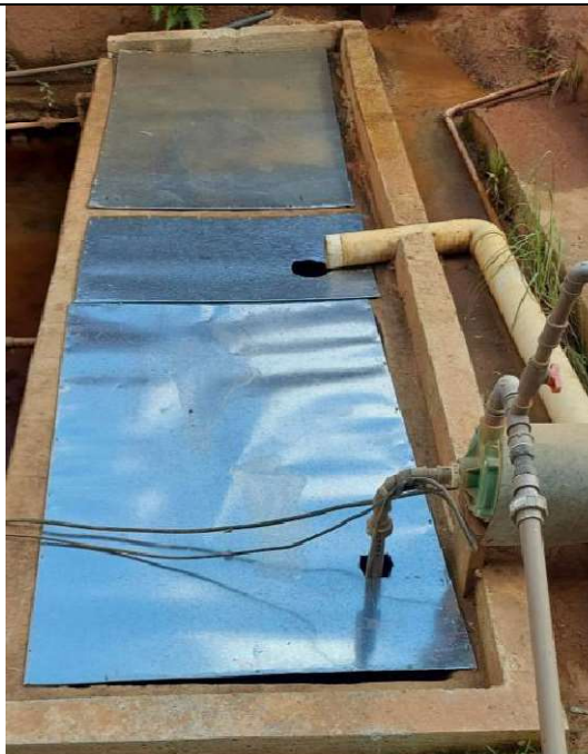
Imagem 05: Vista da CSAO instalada na área de lavagem de caminhões.
