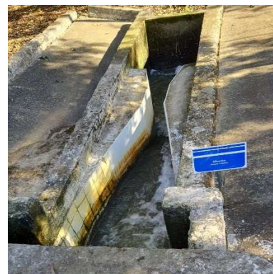
FOTO 4 – Calha Parshall - saída da ETE
