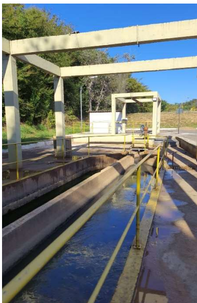
FOTO 1 – Tratamento preliminar e Estação Elevatória de Esgoto
