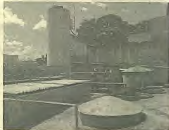
Foto 4: Estação de tratamento de efluentes industriais - chegada do efluente, tratamento físico-químico e leito de secagem do lodo
