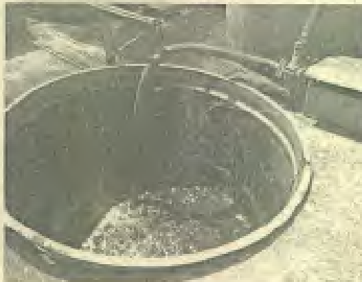
Foto 3: Estação de tratamento de efluentes industriais.
