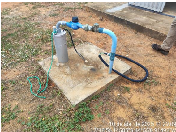
Poço tubular com laje de proteção e equipamentos de medição
