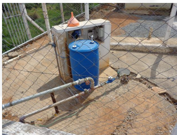
Foto 04. Poço dotado de hidrômetro e horímetro.
