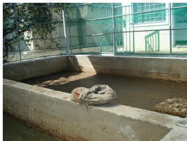
Foto 06. Leito de secagem de lodo da ETE.
