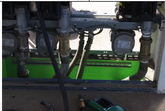
Foto4: Bomba com Sump, Check Valve e Sump
