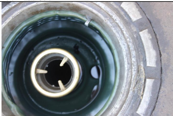
Foto3: Boca de Carregamento Com Sump
