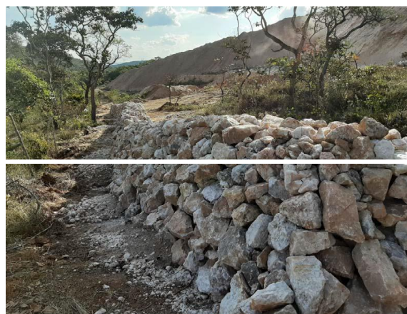
Foto 10. Jusante da pilha de rejeito/estéril – muro de contenção.
