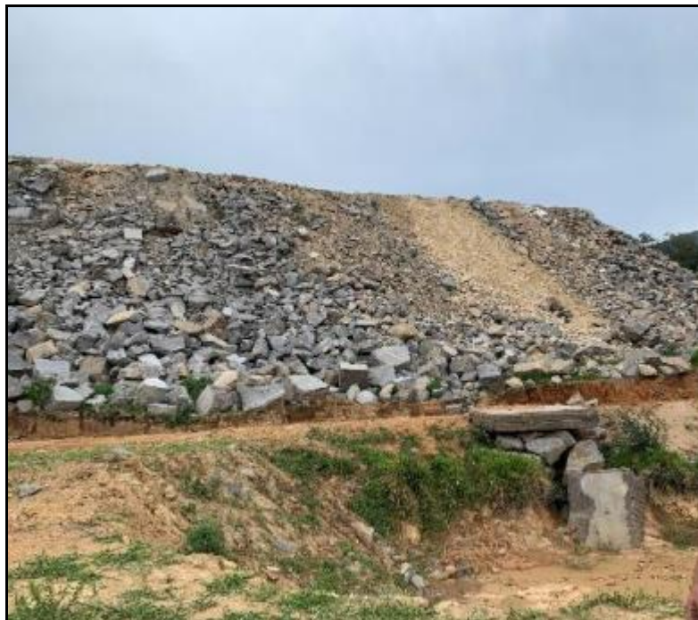
Figura 05: Material depositado no corpo da pilha.
