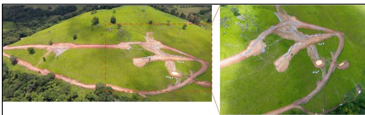
Figura 15: Sistema de drenagem interna realizado na pilha.
