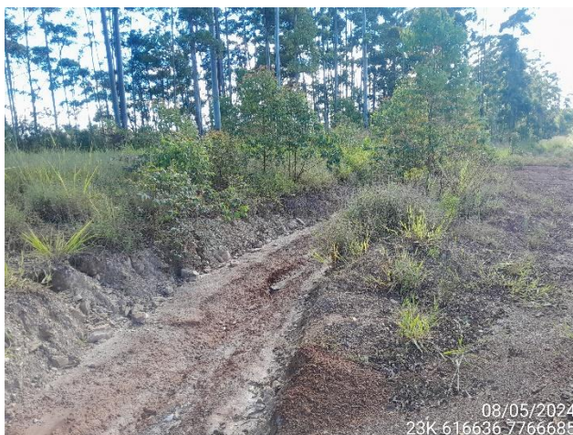
Foto 17: Formação de processo erosivo na porção oeste, abaixo da barreira de terra localizada na alça sul, próximo À BR-356.
