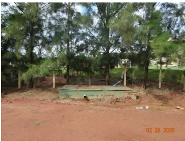
Figura 5. CSAO instalada na portaria (desinfecção de veículos)
