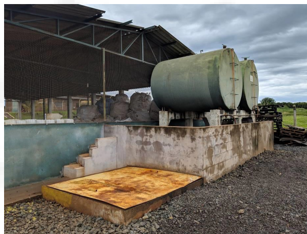
Figura 2. Armazenamento de óleo mineral, bacia de contenção e CSAO Fonte: EIA, 2021
