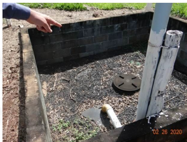
Figura 8. Fossa biodigestora (refeitório e escritório)
