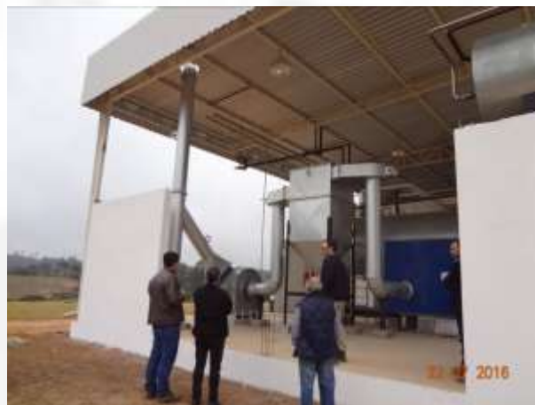
Fig. – Sistema de mitigação do lançamento de emissões atmosféricas, multiciclones.
