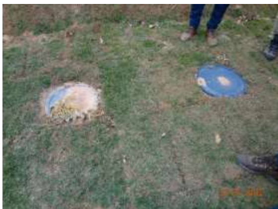
Fig. – Fossa e filtro, boca de visita das estruturas pré moldadas.
