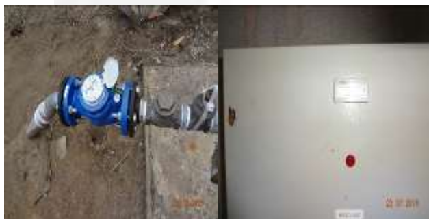
Fig. – Horímetro e Hidrômetro instalados no poço 2
