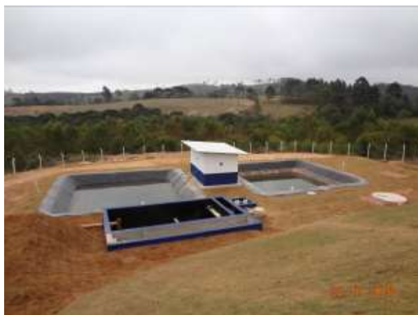
Fig. – Vista do tratamento primário da ETEI.
