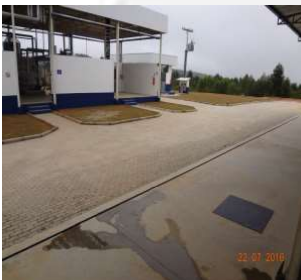
Fig. – Piso impermeável coberto, com canaletas de condução, direcionam o efluente para a ETEI.
