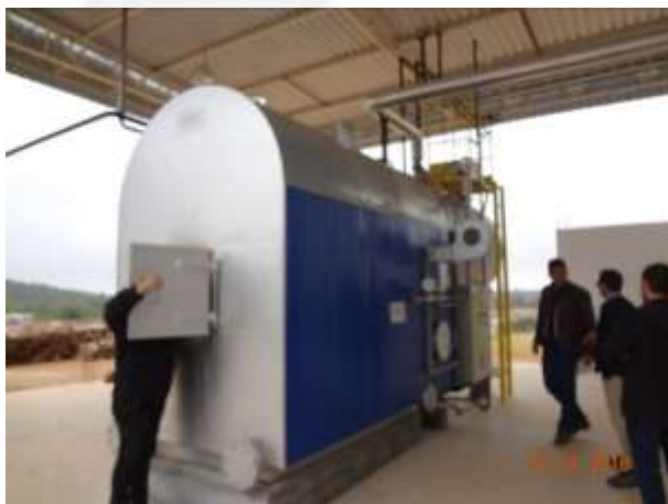
Fig. – Caldeira responsável pela geração de calor capacidade 2.500 kg.vapor/h
