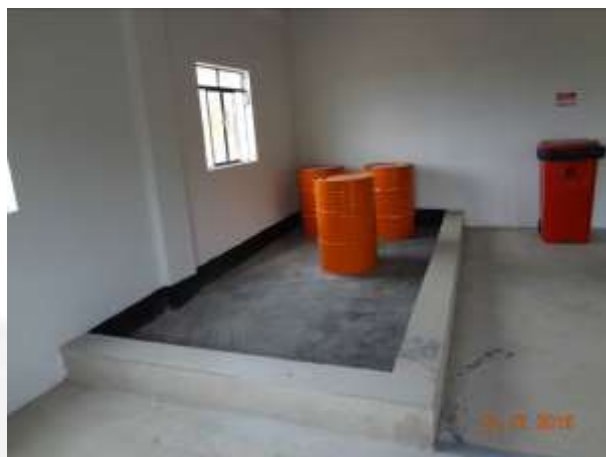
Fig. – Baia impermeabilizada, com bacia de contenção, para acomodação dos resíduos classe I.
