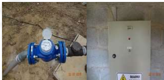
Fig. – Horímetro e Hidrômetro instalados no poço 1
