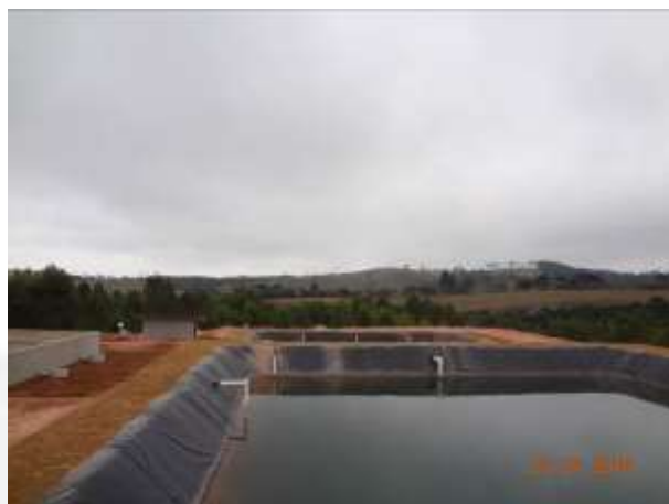
Fig. – Vista parcial do sistema de tratamento secundário da ETEI.
