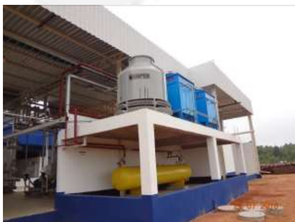
Fig. – Sistema de armazenamento de amônia com torre de resfriamento, local com bacia de contenção e localizado em área externa.
