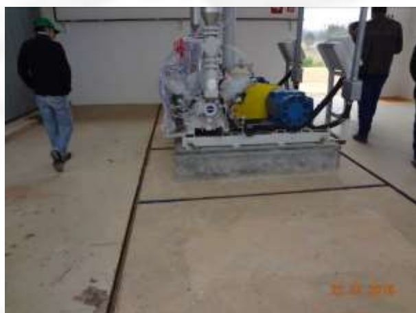
Fig. – Compressores de amônia, automatizados, funcionamento de acordo com a necessidade de resfriamento.
