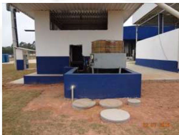
Fig. – Bacia de contenção do armazenamento de óleo diesel, acoplado a esta existe uma caixa SAO.
