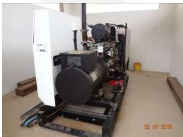
Fig. – Gerador fica em “standy by”, para casos de interrupção no abastecimento público de energia elétrica.
