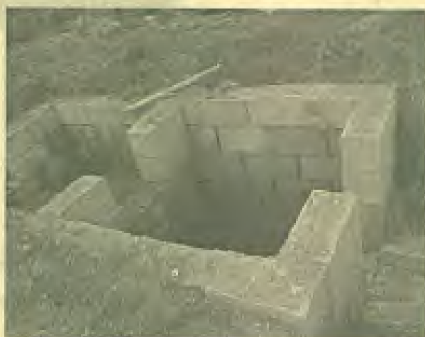
Foto 02. Caixas de sedimentação
