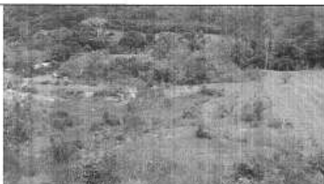
Foto 11: Área do barramento inativo
