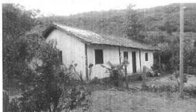
Foto 10: Casa que será demolida para realizar o desvio da pousada
