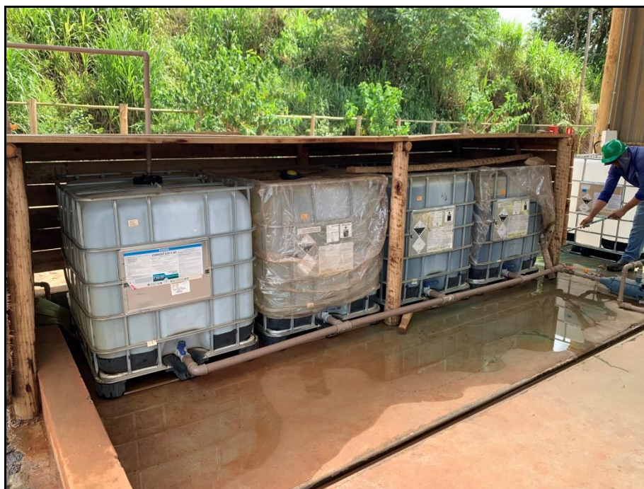
Figura 06 – Depósito para armazenamento de insumos químicos (produto preservativo e neutralizante).
