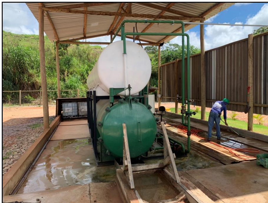
Figura 05 – Segunda autoclave do empreendimento com as medidas de controle ambiental implantadas
