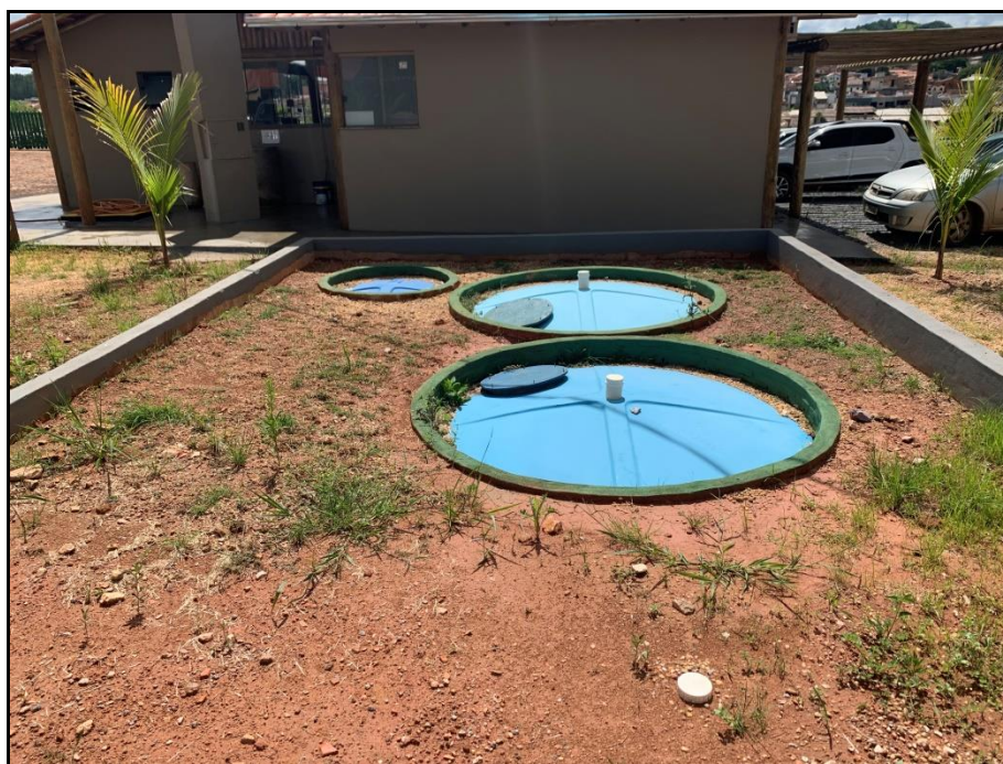
Figura 07 – Tratamento dos efluentes sanitários constituídos de tanque séptico, filtro anaeróbio e sumidouro.
