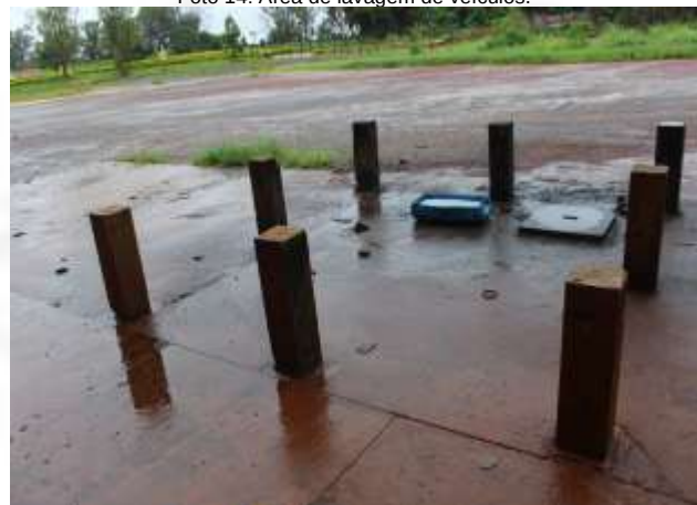
Foto 14: Área de lavagem de veículos.
