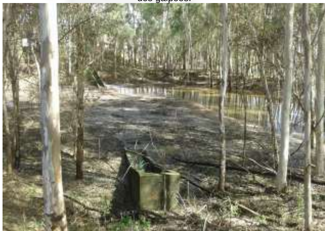
Foto 61: Bacia de contenção pluvial que também recebe efluente da área dos galpões.
