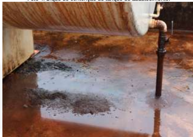
Foto 4: Dique de contenção do tanque de abastecimento.
