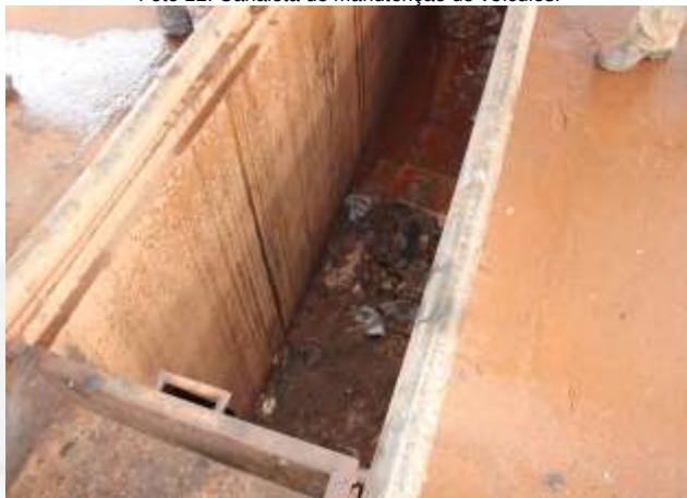
Foto 12: Canaleta de manutenção de veículos.
