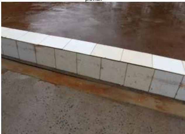
Foto 31: Canaleta com efluente industrial sendo destinada a drenagem pluvial.
