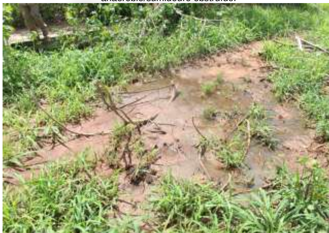
Foto 55: Efluente sanitário escoado de sistema fossa séptica/filtro anaeróbio/sumidouro obstruído.
