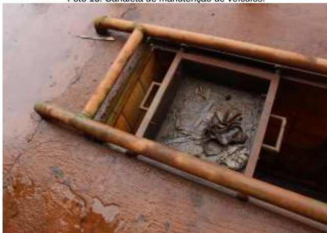
Foto 13: Canaleta de manutenção de veículos.
