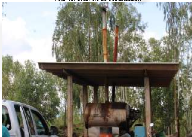
Foto 46: Chaminé do desidratador.
