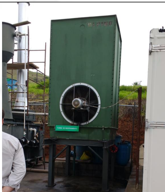
Incinerador – torre de resfriamento
