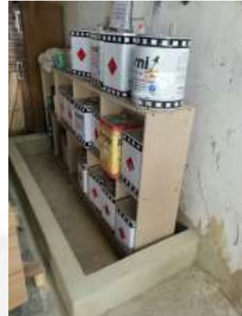
Figura 8: Bacia de contenção no estoque de consumo diário.
