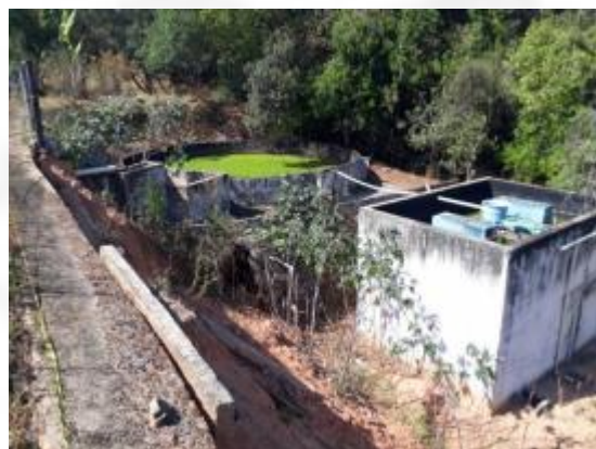
Foto 04. Tanque Equalizador e do Reator UASB.
