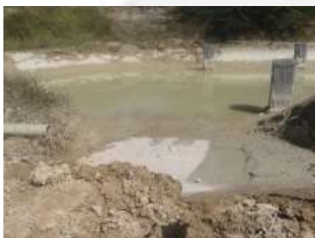
Foto 01: Tanque de decantação com filtros
