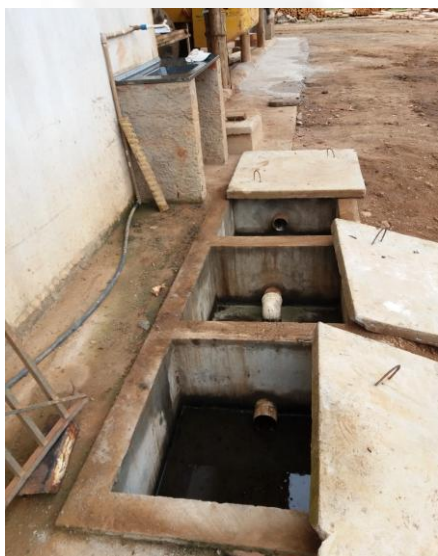
Foto 09: Sistema separador água e óleo.
