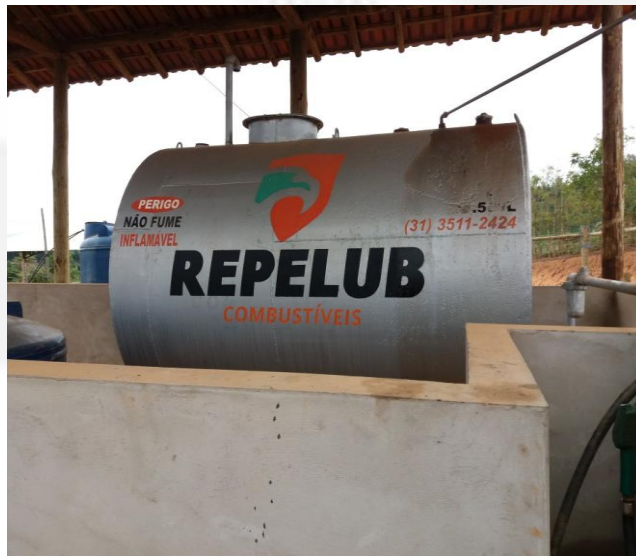
Foto 10: Tanque aéreo de diesel.
