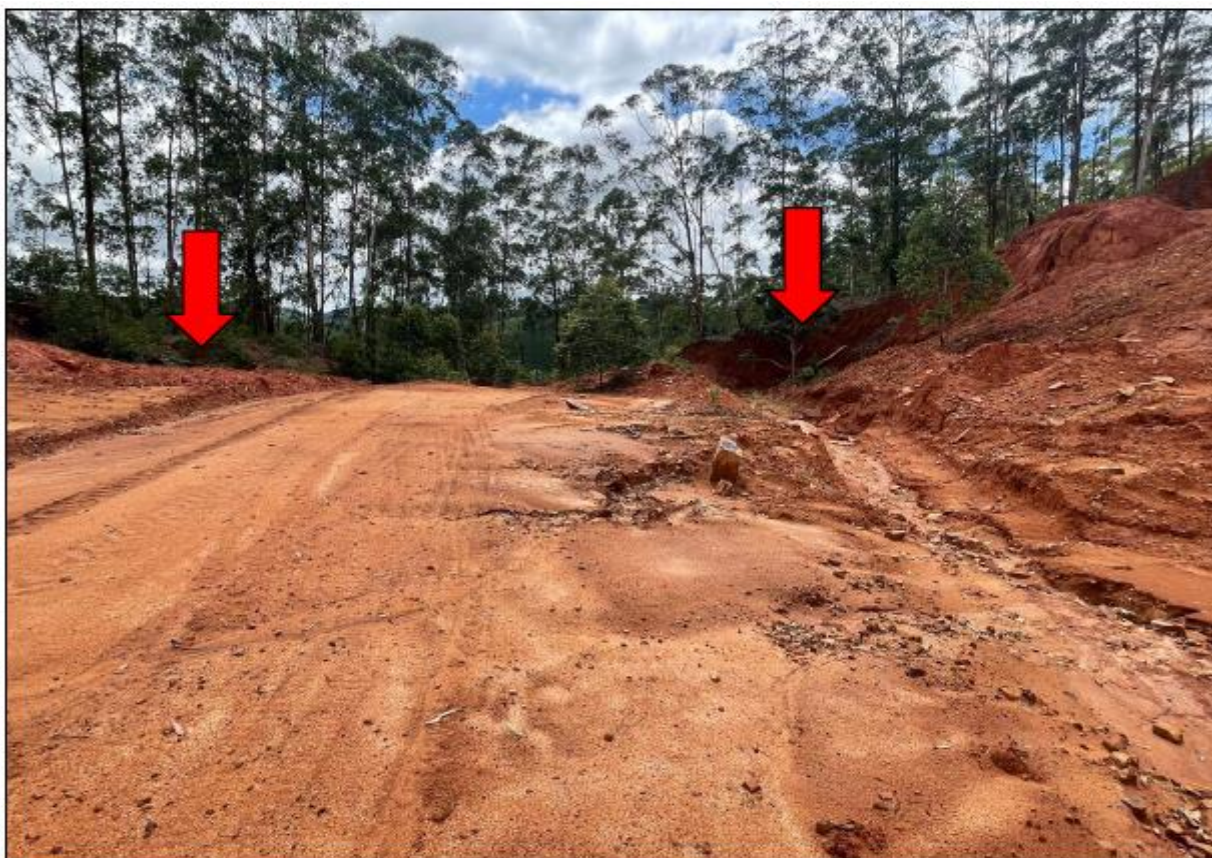
Imagem 2: Vista das calhas de drenagem identificada pelas setas, página 30, do RAS. É possível ver processos erosivos na via de acesso
