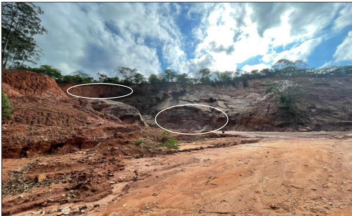
Imagem 1: Vista da área de interesse, mostrando processo erosivos e, taludes, sem conformação, com ângulos negativos (círculos brancos), página 28, do RAS
