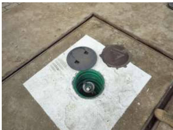
Foto 04. Boca de descarga dos tanques
