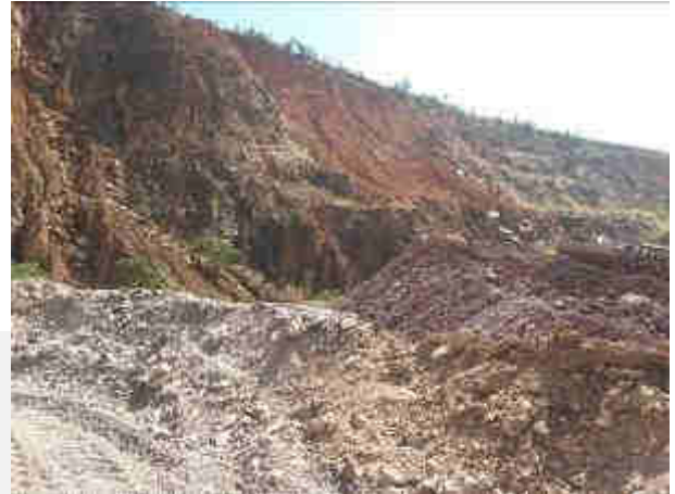
Foto 04. Área em processo de retaludamento
