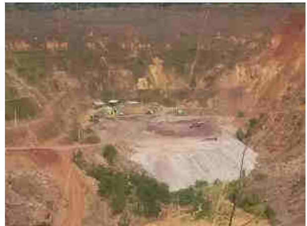
Foto 02. Visão geral do empreendimento
