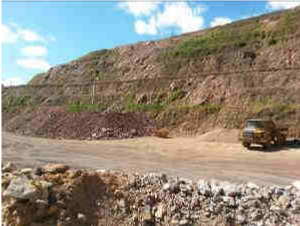
Foto 03. Retaludamento e revegetação previstos no PRAD
