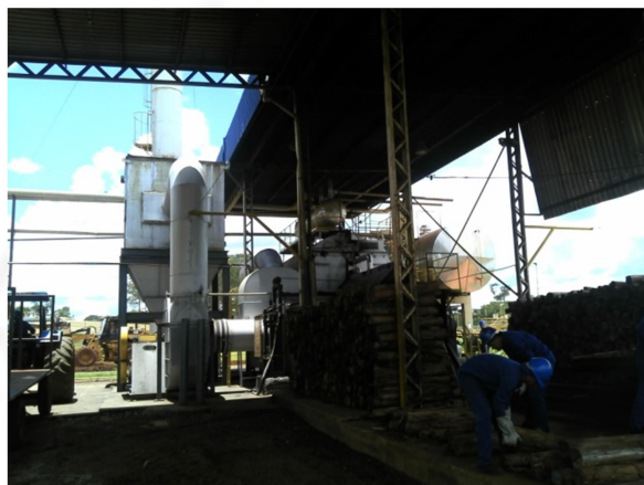
Caldeira a biomassa com sistema multiciclone.
