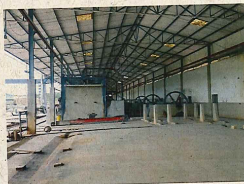
Figura 5: Galpão de instalação do tear multifio.
