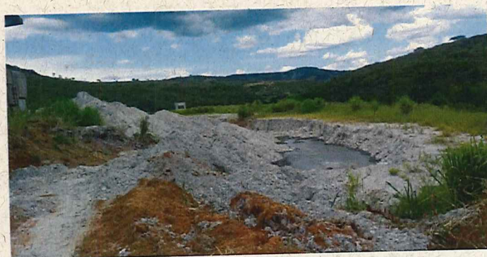
Figura 7: Bacia de sedimentação/decantação.
