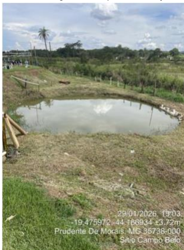
Imagem 03: Tanque de decantação
