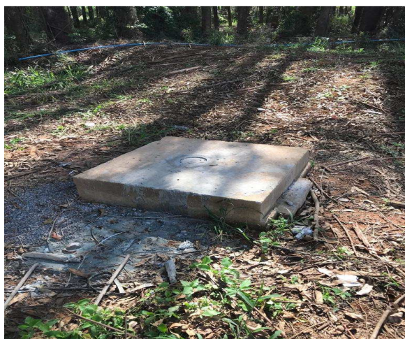
Poço tubular em desuso – lacrado
