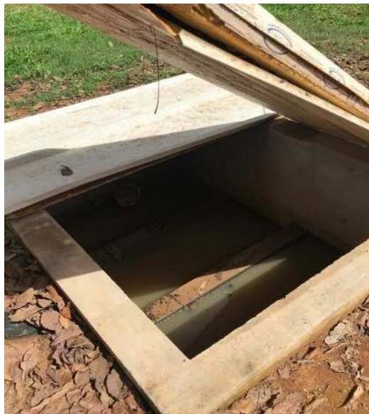
Caixa separadora de água e óleo do ponto de abastecimento
