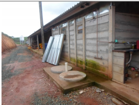
4 - Fossa séptica instalada junto a cada galpão.
