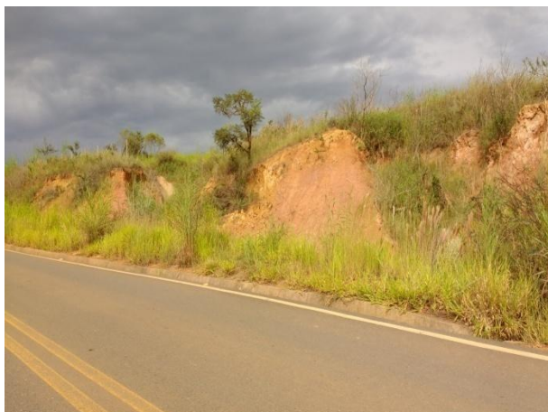
Foto 09. Ponto 33 AF - LD - talude de corte com sinais de deslizamento de material
