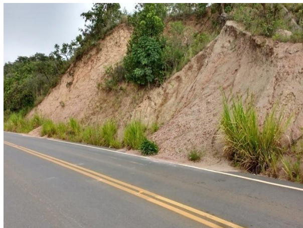
Foto 12. Ponto 44 AF - LD - talude de corte com sinais de deslizamento de material
