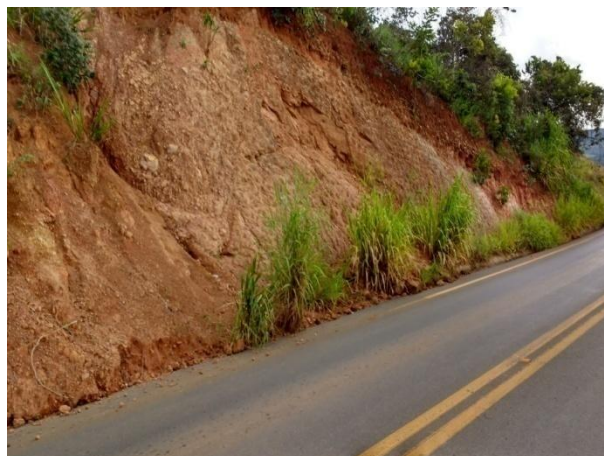
Foto 10. Ponto 42 AF - LD - talude de corte com sinais de deslizamento de material
