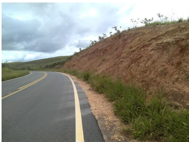
Foto 03. Ponto 17 AF - LE - talude de corte com sinais de deslizamento de material
