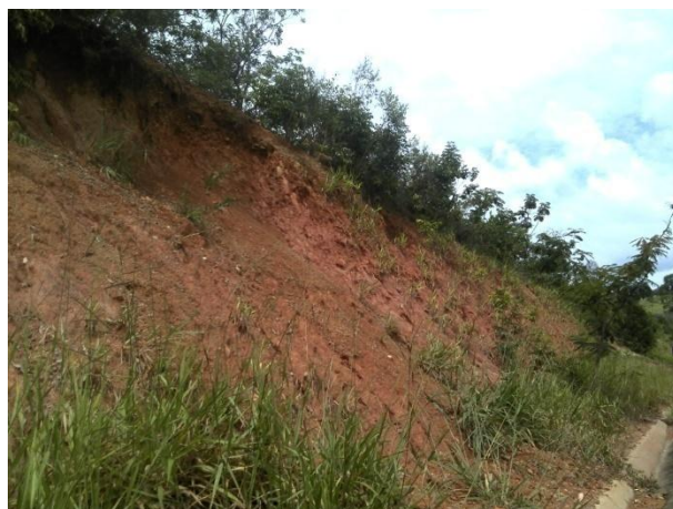
Foto 04. Ponto 24 AF - LD - talude de corte com sinais de deslizamento de material
