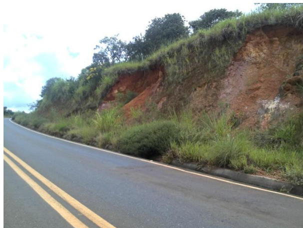
Foto 08. Ponto 28 AF - LE - talude de corte com sinais de deslizamento de material
