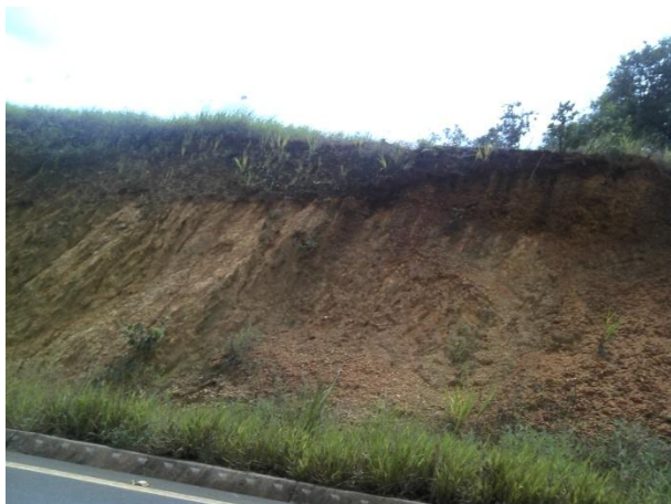
Foto 07. Ponto 27 AF - LE - talude de corte com sinais de deslizamento de material
