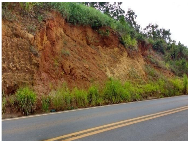
Foto 11. Ponto 43 AF - LD - talude de corte com sinais de deslizamento de material
