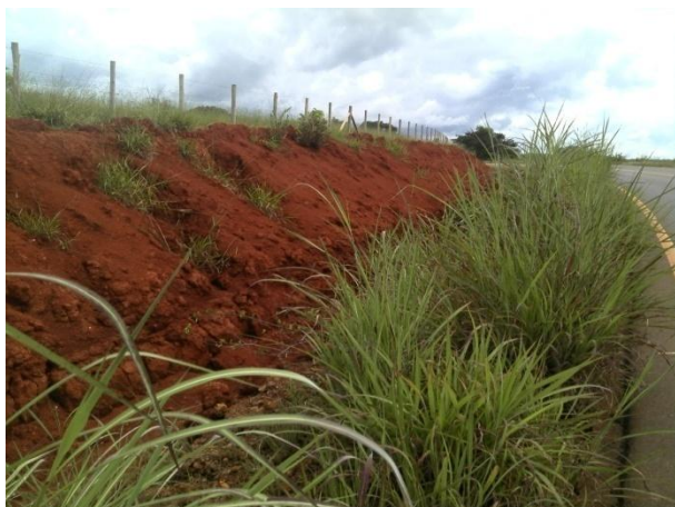
Foto 05. Ponto 25 AF - LD - talude de corte sem cobertura vegetal
