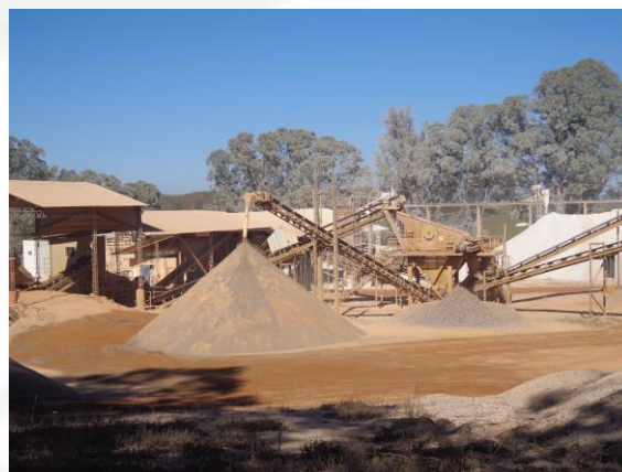
Foto 02. Unidade de britagem
