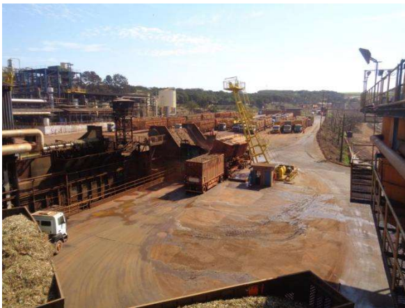
Figura 1- Vista da usina com destaque para área de recepção de cana-de-açúcar
