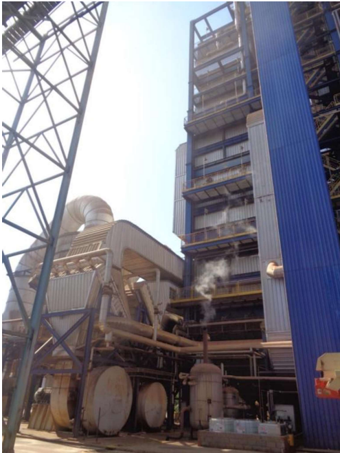
Figura 5- Caldeira e lavador de gases
