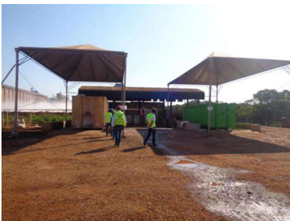
Figura 3-Central de recebimento de resíduos
