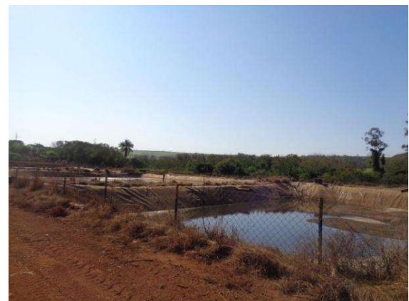
Figura 4- Reservatórios de vinhaça/águas residuárias
